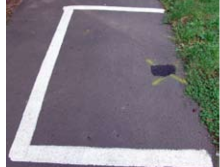
Verräterische Bohrlöcher wie dieses, zeugen von den Probebohrungen.
