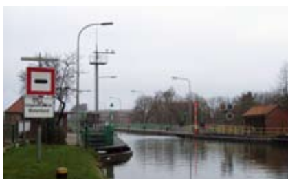
Die Schleuse in Limmer.
