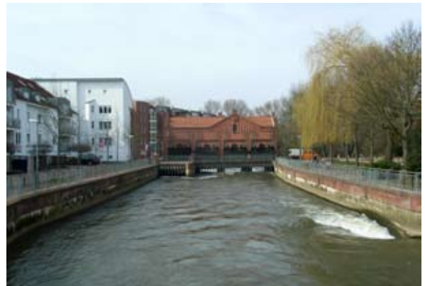
Aus diesem Kanal soll die Energie für die Klimaschutzsiedlung erzeugt werden
